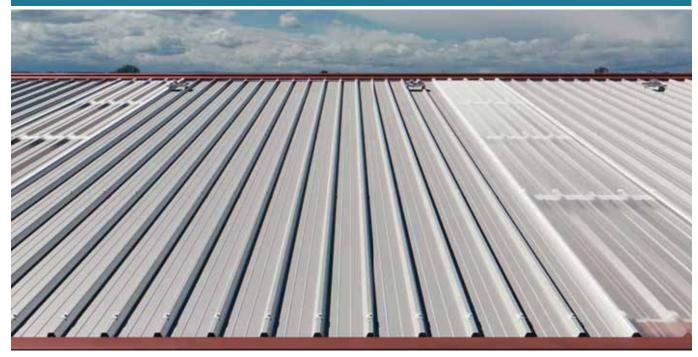
Panel sándwich de doble revestimiento metálico, para cubiertas con pendiente no inferior al 7%, aislado en poliuretano, con lámina exterior perfilada de 5 grecas para aumentar la resistencia a las cargas estáticas y dinámicas. La fijación es a vista con grapas metálicas con guarnición. Se usa también para recubrir fachadas.
