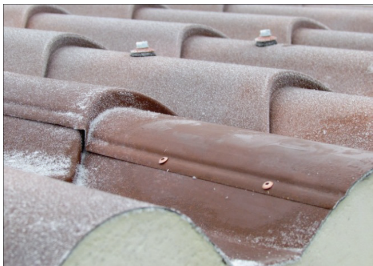
Esempio di corretto impiego di rivetti
