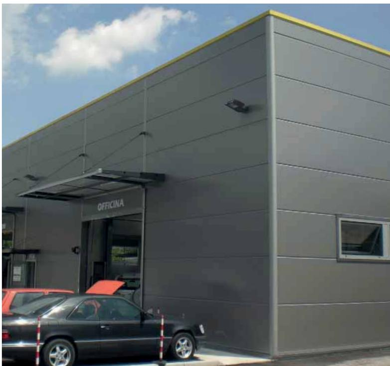
Elementele de inchidere unghiulare izolate, sisteme R.A.C., sunt profile de finisaj dezvoltate special pentru peretii realizati cu panouri Isopan. Aceste inchideri izolate sunt confectionate in baza desenelor clientului si in functie de cerintele lucrarii; de asemenea se pot utiliza finisaje practice, elegante confectionate in functie de dimensiunile cerute de proiect.
